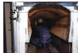
緊急設備点検
