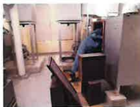
火葬炉設備清掃
