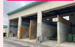
現在のストックヤード棟
