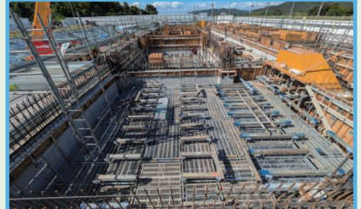
地下処理水槽の建設を終えて、上屋の鉄骨工事を進めています。
