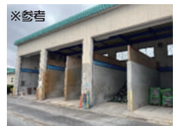
クリスタルプラザ ストックヤード棟
