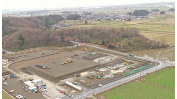
現場状況写真（R6.2月末時点）
