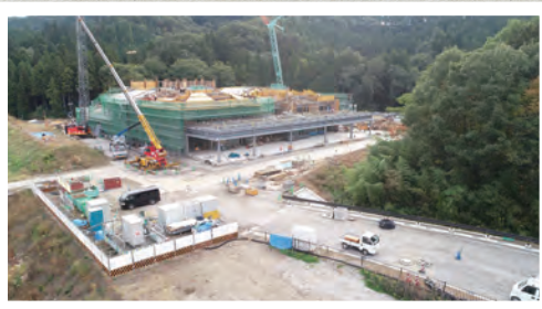
新斎場 建設進捗状況
